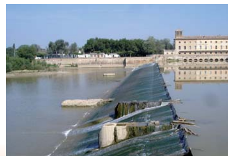
Figura 9.10. Azud y central fluyente en el río Ebro
