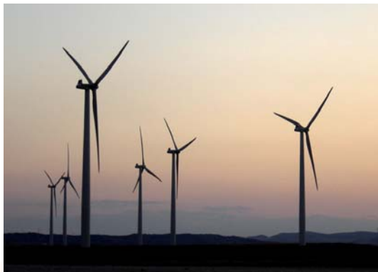
Figura 9.1. Parque eólico instalado en el Valle del Ebro
