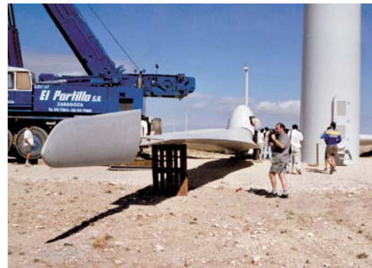
Figura 9.3. Montaje de un aerogenerador
